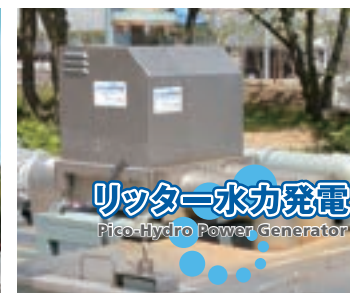
マイクロ水力発電設備 1.0kW×1台
