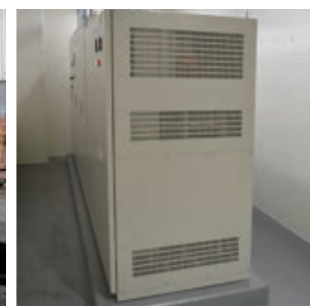
充電池及び電力変換盤
