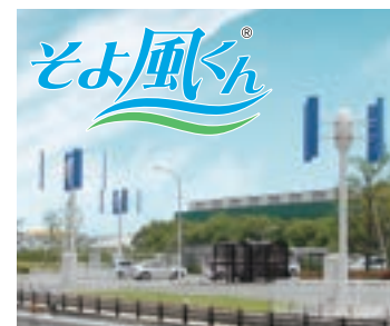
小形風力発電設備 1.84kW×3台
