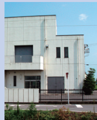
仁井田 水処理センター (公共下水道)
