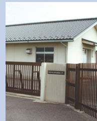
東部地区 水処理センター (農業集落排水)
