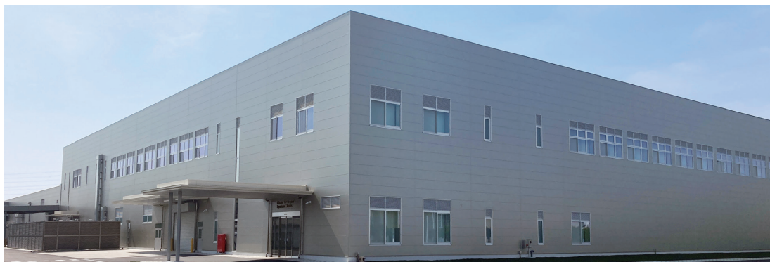
豊橋製作所に増築中のクリーン搬送システム工場
