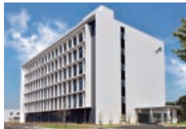
技術開発センター（新技術棟）
