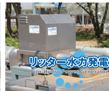
マイクロ水力発電設備 1.0kW×1台
