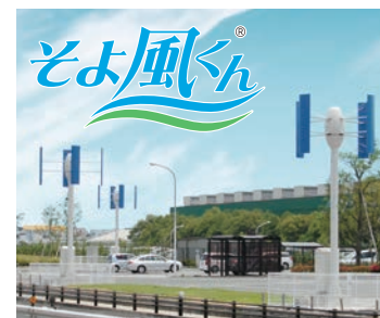
小形風力発電設備 1.84kW×3台
