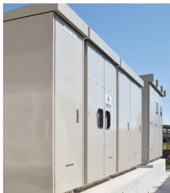
充電電池及び電力変換盤
