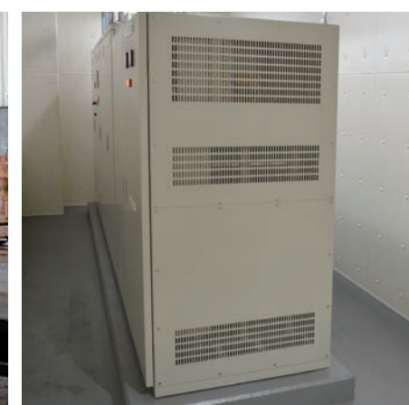
充電電池及び電力変換盤
