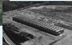
豊橋工場建設時/1965年
