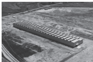
1965(昭和40)年 豊橋工場建設時
