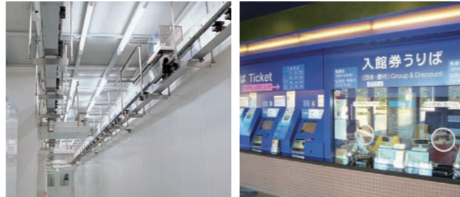
搬送工事(半導体クリーンルーム)
