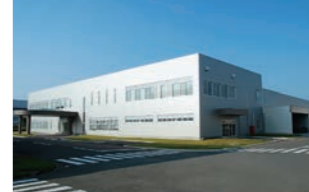
2007(平成19)年 クリーン搬送機器工場(豊橋)
