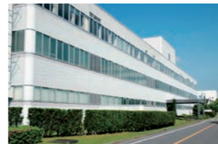
1991(平成3)年 航空電機工場(伊勢)
